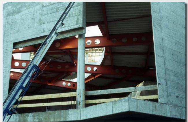
Blick in den Großen Sitzungssaal mit den Stahlträgern der Deckenkonstruktion
