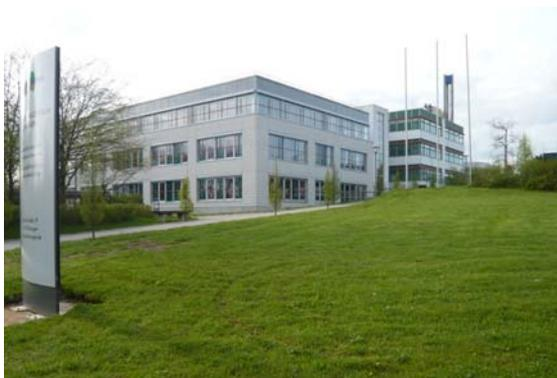
Für 2,215 Millionen Euro wurden sechs Theorie­räume sowie zwei EDV-Räume und ein Lehrer­zimmer mit über 900 m<sup>2</sup> Nutzfläche gebaut. Die Außenwände und das Dach sind in Stahl­konstruktion erstellt. Fassaden und Fensterelemente bestehen aus Aluprofilen. Die Wärmeversorgung wird unter Berücksichtigung ökologischer und ökonomischer Gesichtspunkte größtenteils über die vorhandene Holzhackschnitzelheizungsanlage bewerkstelligt.
