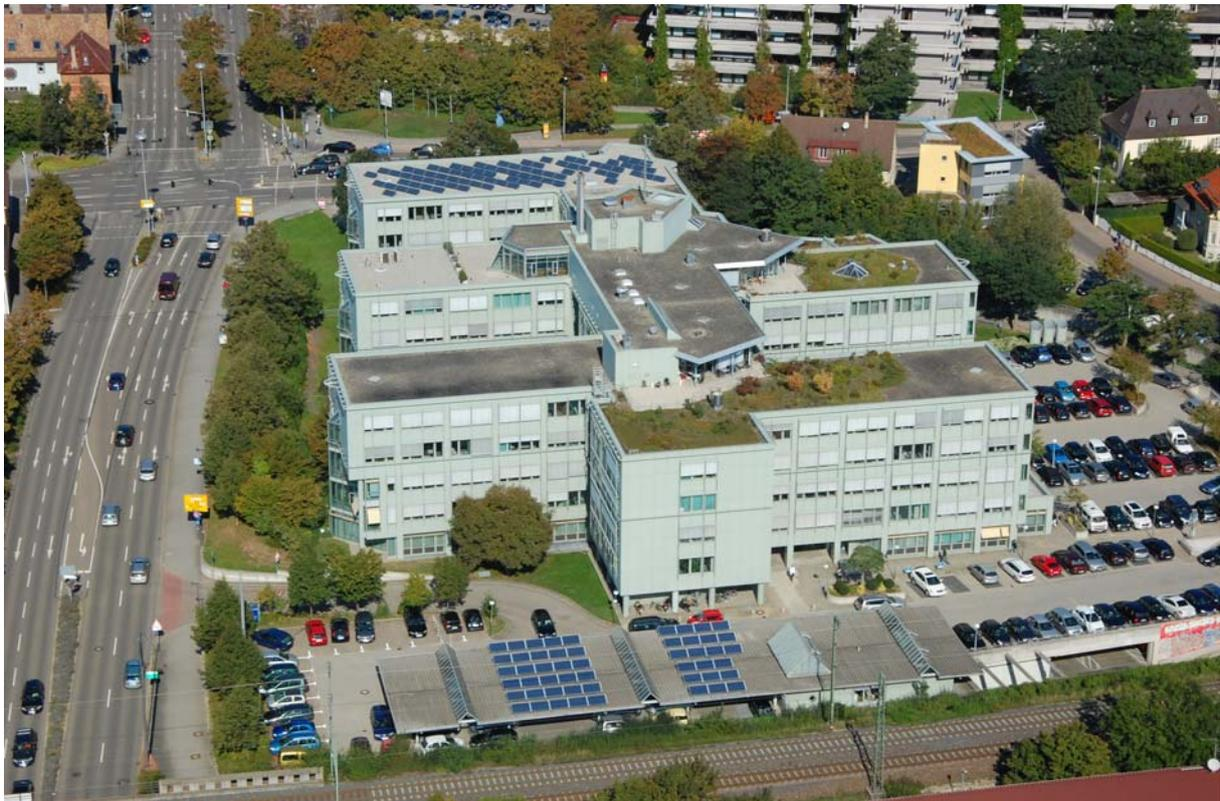
Im Bildvordergrund ist die erste landkreiseigene Photovoltaikanlage auf der Parkplatzüberdachung zu sehen. Auf dem Gebäudedach ist die Photovoltaikgemeinschaftsanlage von insgesamt 15 Beschäftigten der Landkreisverwaltung installiert, die bereits im Jahr 2009 installiert wurde.
