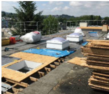
Rückbau Dach + Einbau neue Lichtkuppeln
