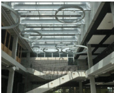
Neue Beleuchtung Aula
