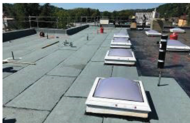
Einbau neuer Abdichtungsbahnen
