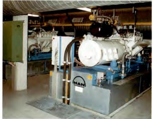
Einer der Verbrennungsmotoren im Blockheizkraftwerk
