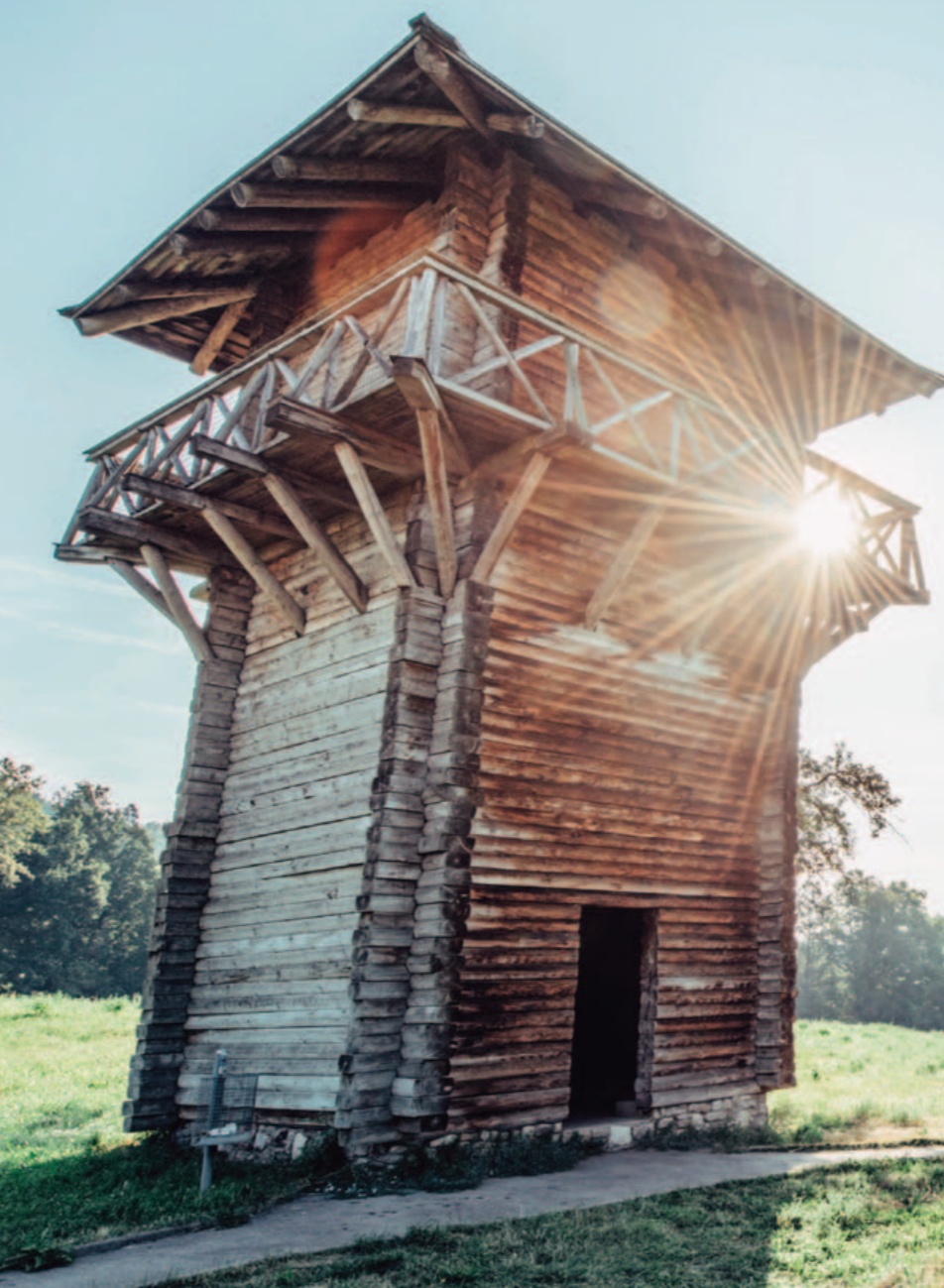
Rekonstruierter Limeswachturm am Limesknie Lorch
