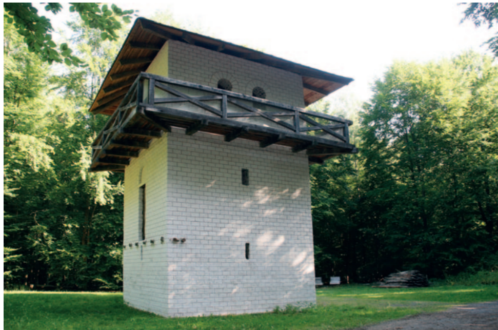
Limeshain, rekonstruierter Steinturm
