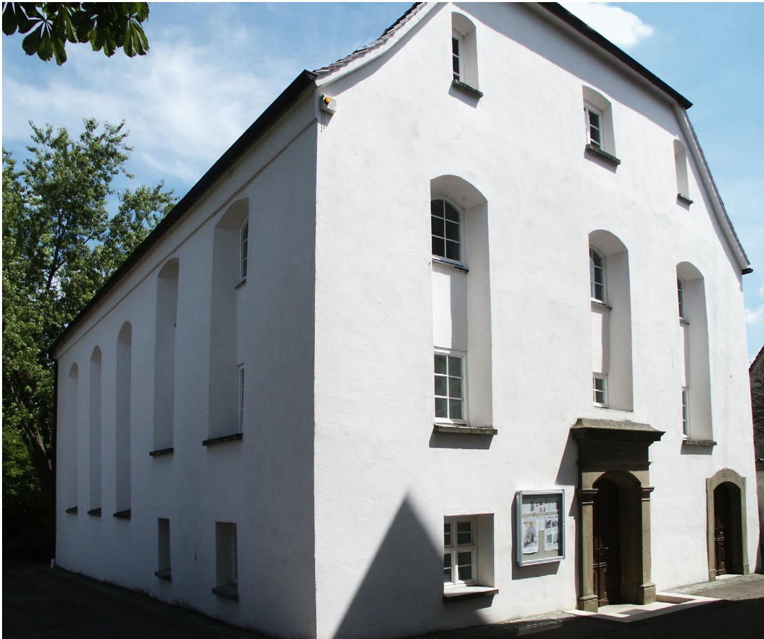
5. Ehemalige Synagoge Bopfingen-Oberdorf
